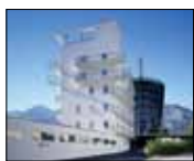
Titelseite | Front Cover Parkhotel Hall i.T., Ansicht Vorplatz. Parkhotel Hall i.T., View from the forecourt.
